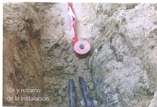
La zanja donde se colocaron los captadores MuoviTech, entre 1 y 1,5 metros de profundidad
