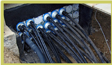
Entrada de sondas geotérmicas al colector
