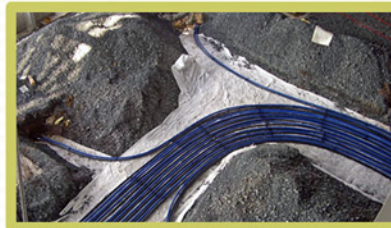
Conexión horizontal de sondas geotérmicas
