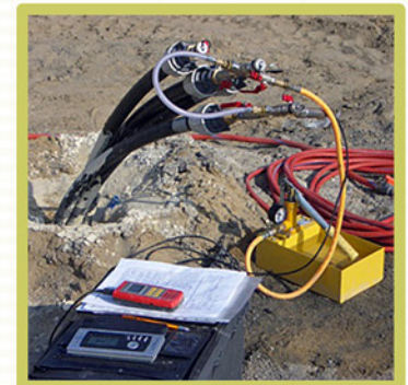
Test de presión in situ
