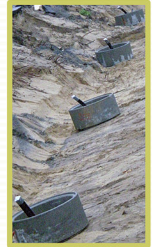
Campo de sondas para instalación colectiva
