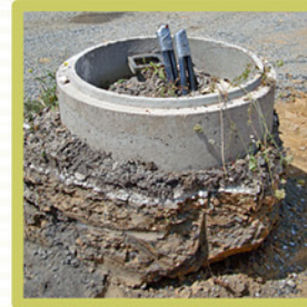
Detalle de instalación de una sonda geotérmica
